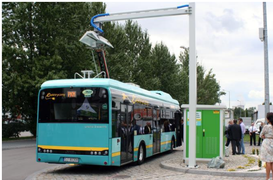
Rysunek 8: Pantografowa stacja ładowania autobusów elektrycznych w Jaworznie, źródło: https://www.transport-publiczny.pl/img/jaworznostacja1.jpg_678-443.jpg
