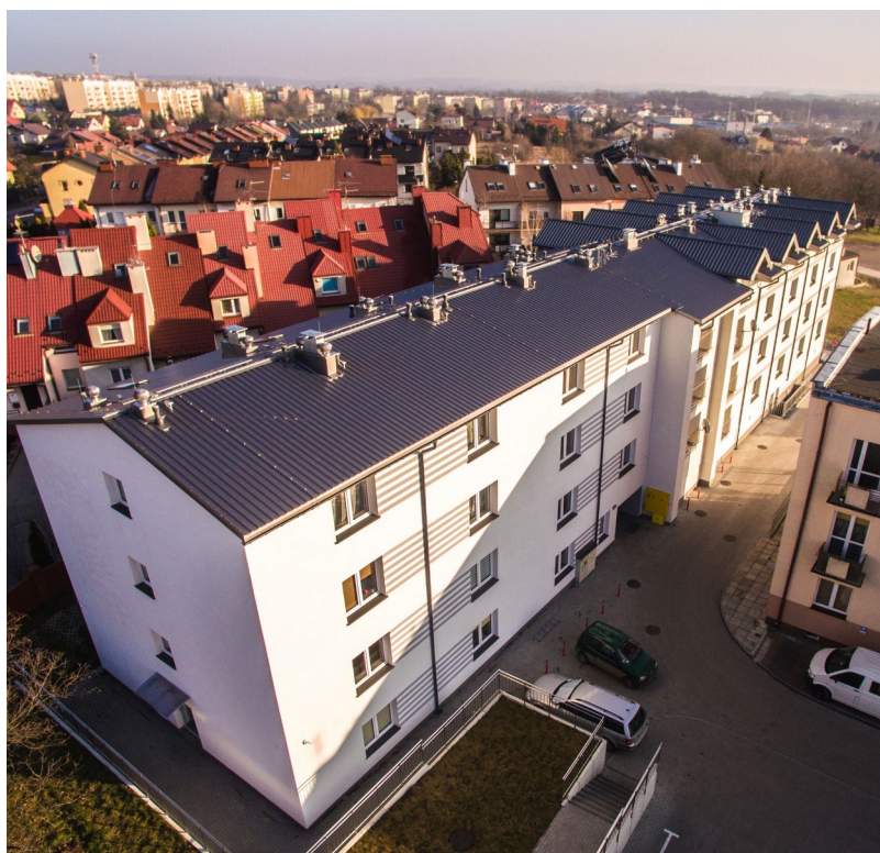
Zdjęcie 14. Budynek z mieszkaniami socjalnymi
