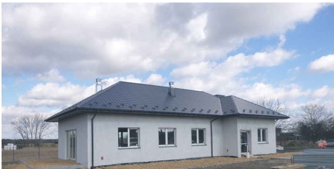
Zdjęcie 17. Budowa świetlicy w Kołaczkowicach
