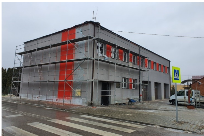
Zdjęcie 8. Budynek OSP w Zbludowicach w trakcie robót termomodernizacyjnych
