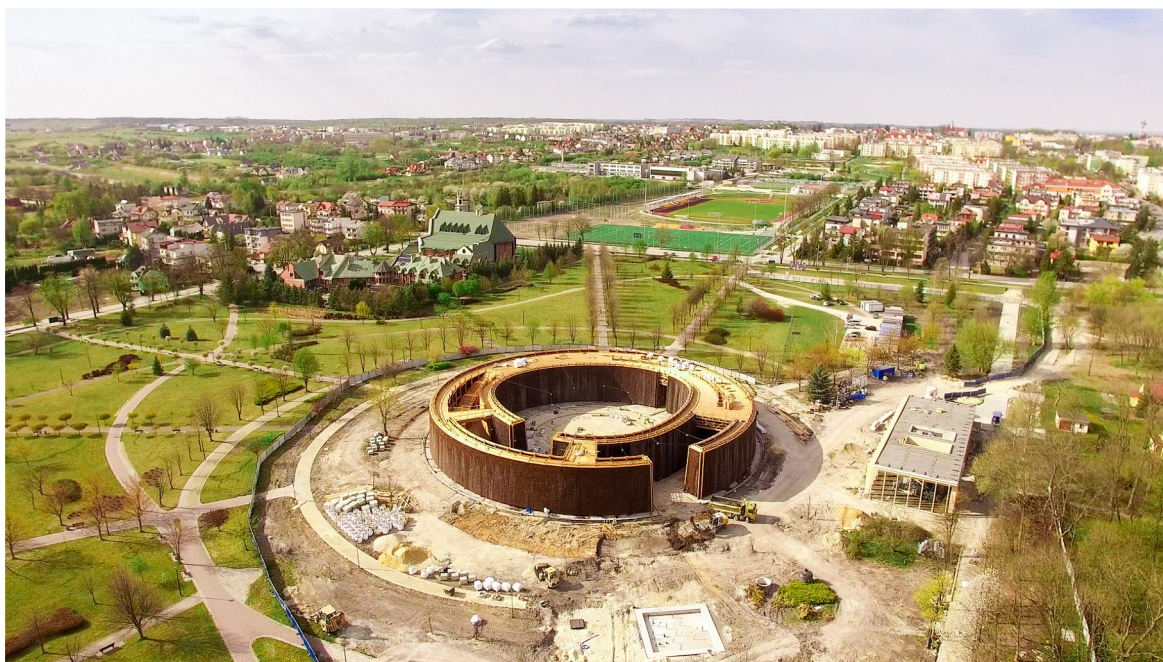
Zdjęcie 12. Budowa tężni
